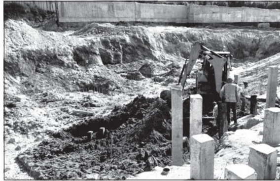
Рис. 4. Подготовка грунтов основания под плитную часть плитно-свайного фундамента при строительстве физкультурно-оздоровительного комплекса с плавательным бассейном в Магадане
