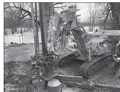
Рис. 1. Струйная цементация мерзлых грунтов в лотках
