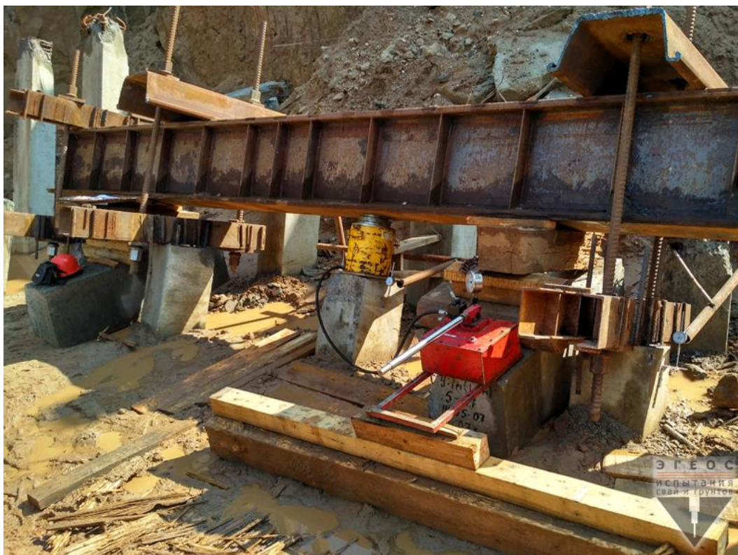
Проведение статического испытания наклонной сваи, Московская область
