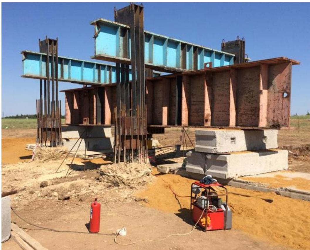
Испытательный стенд для передачи нагрузок до 1000 тс, использованный ООО «ЭГЕОС» при работах на объекте в Ростовской области
