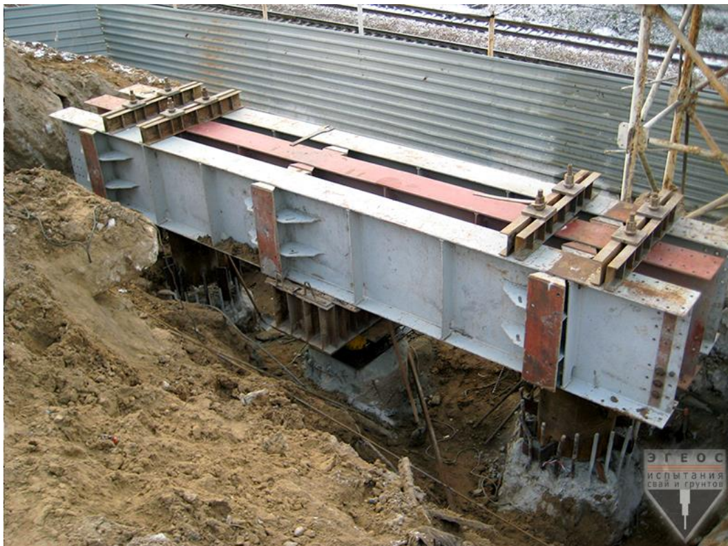
ООО «ЭГЕОС» выполняет статические испытания при строительстве путепровода, г. Москва
