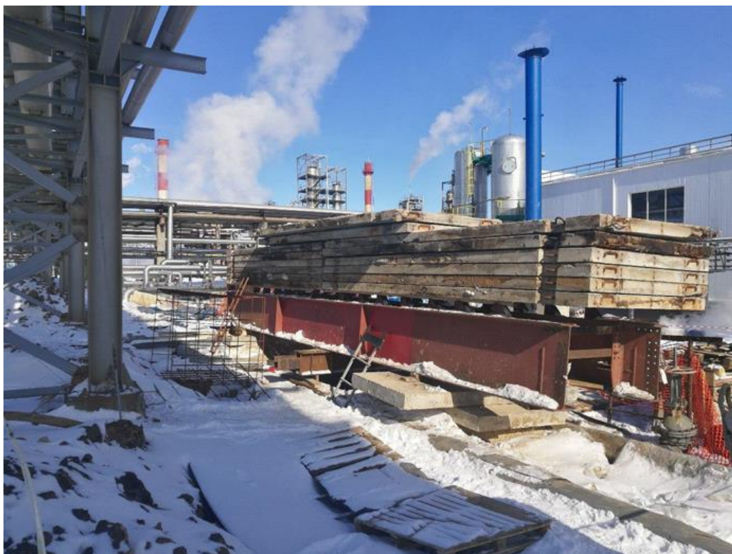
ООО «ЭГЕОС» выполняет статические испытания на строительстве завода, г. Рязань
