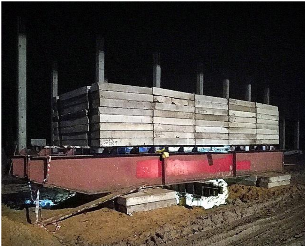
Проведение статического испытания свай на строительстве завода, Тульская область
