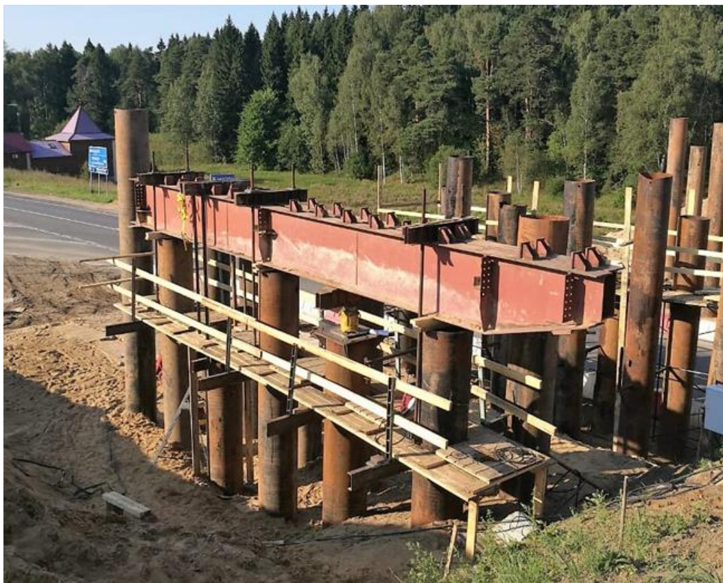
Контрольные испытания стальной круглой полый сваи статической нагрузкой, Московская область
