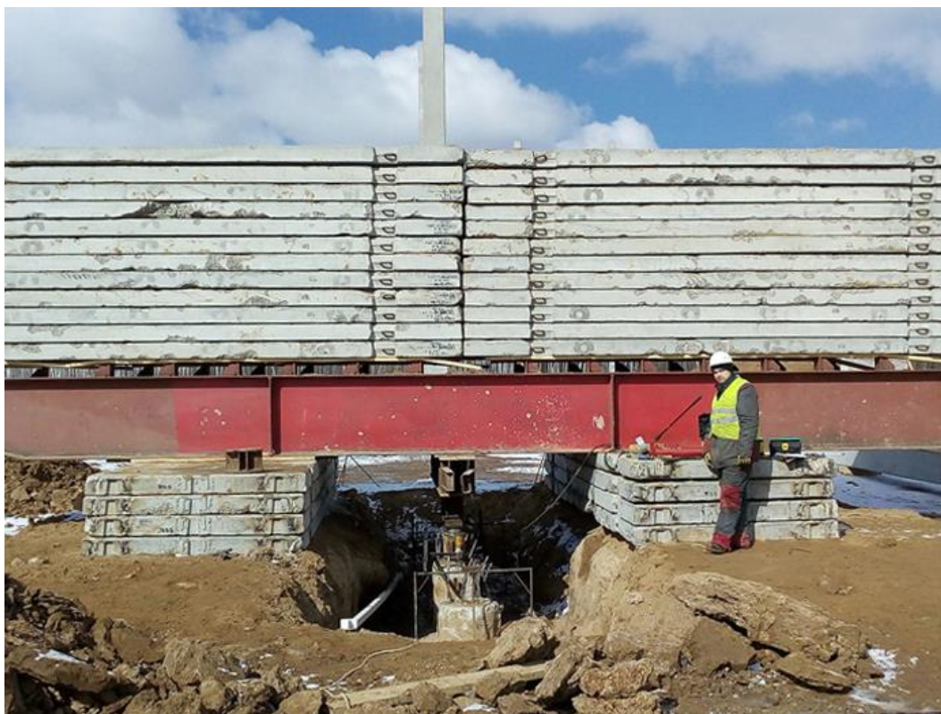
Испытательный стенд для передачи нагрузок до 120 тс, использованный ООО «ЭГЕОС» при работах на объекте в Московской области
