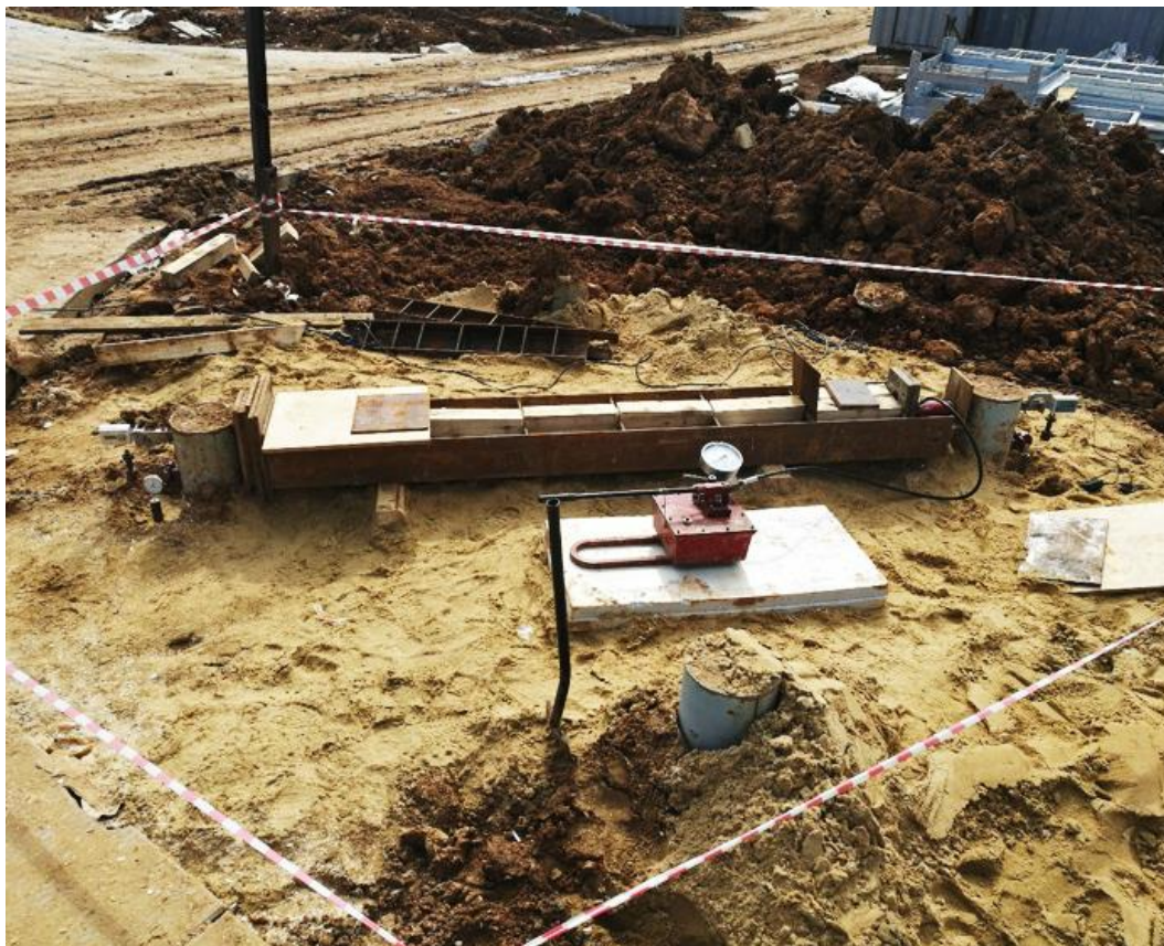
Контрольные испытания статической выдергивающей нагрузкой, Московская область
