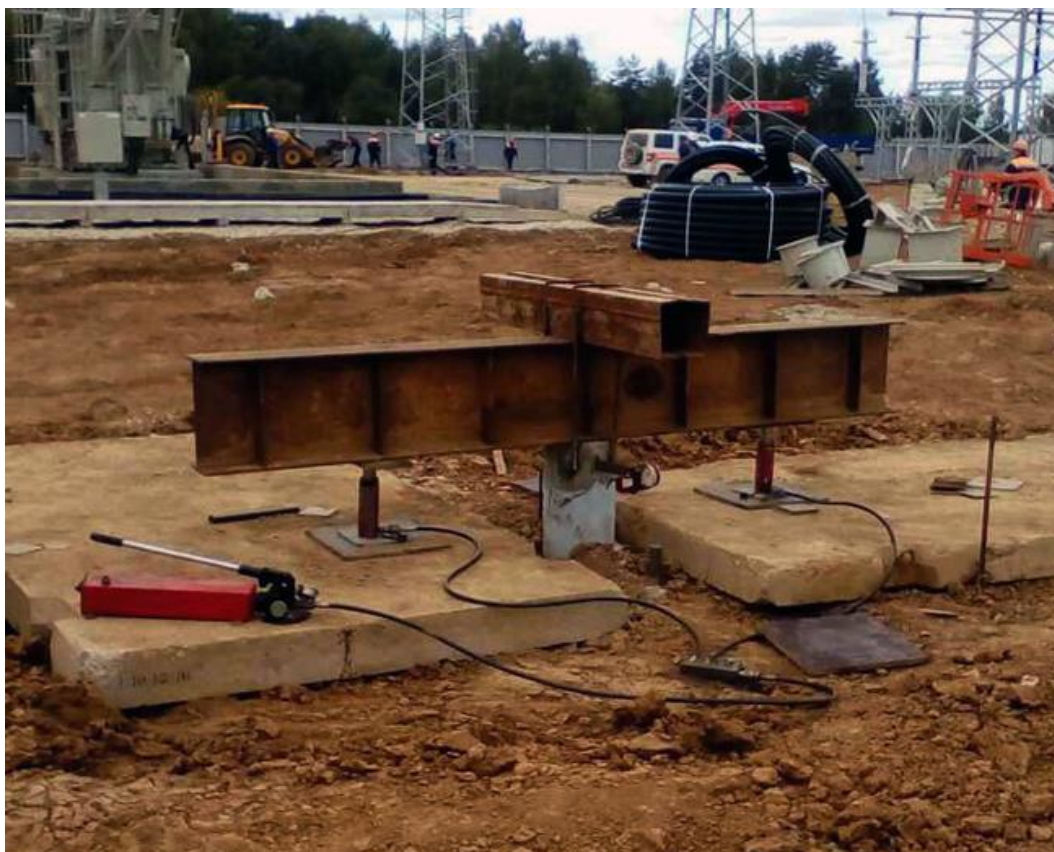
Испытательный стенд для проведения испытания выдергивающей нагрузкой, Московская область
