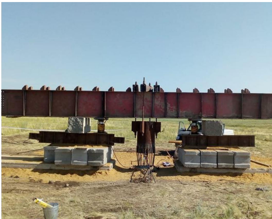
Испытательный стенд ООО «ЭГЕОС» для передачи выдергивающей нагрузки до 200 тс, Ростовская область
