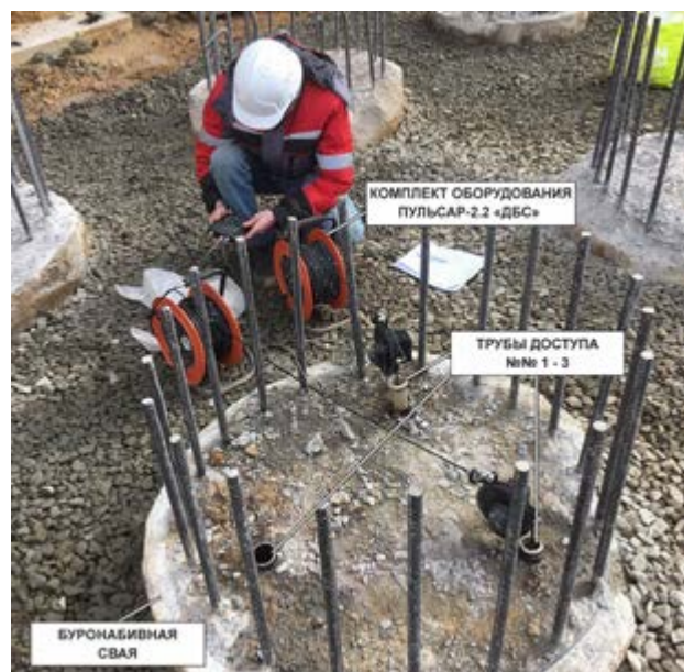
Рис. 1. Контроль сплошности буронабивных свай ультразвуковым методом
