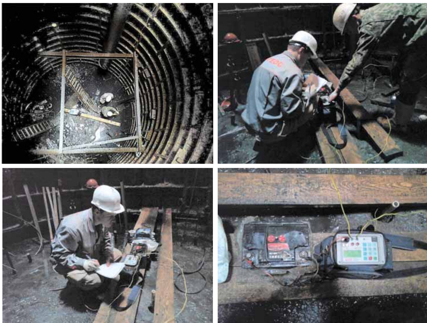
Рис. 3. Проведение геофизических исследований методом электроразведки в вентиляционном стволе метрополитена
